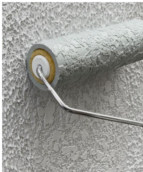
魔法ローラーによる塗装作業
