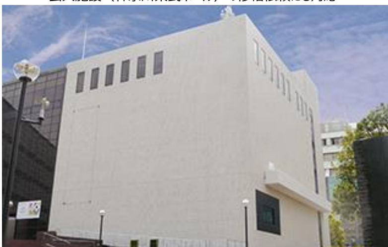
公共施設（神奈川県民ホール）の修繕依頼にも対応
